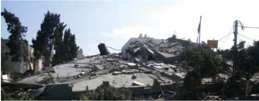
بقايا مبنى الرقابة والمالية والإدارية غرب مدينة غزة
