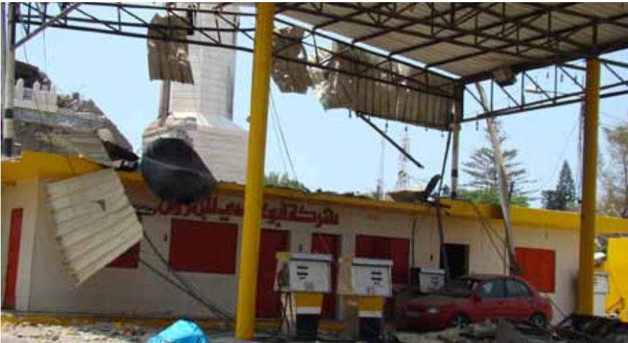
آثار الدمار الذي حل بمحطة أبو عاصي للبتروكيمياويات جراء القصف الإسرائيلي للمسجد المجاور في شارع الوحدة بمدينة غزة
